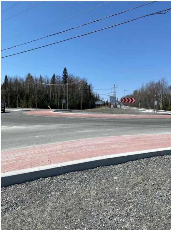
Vue vers l'ouest (boulevard Barrette)
