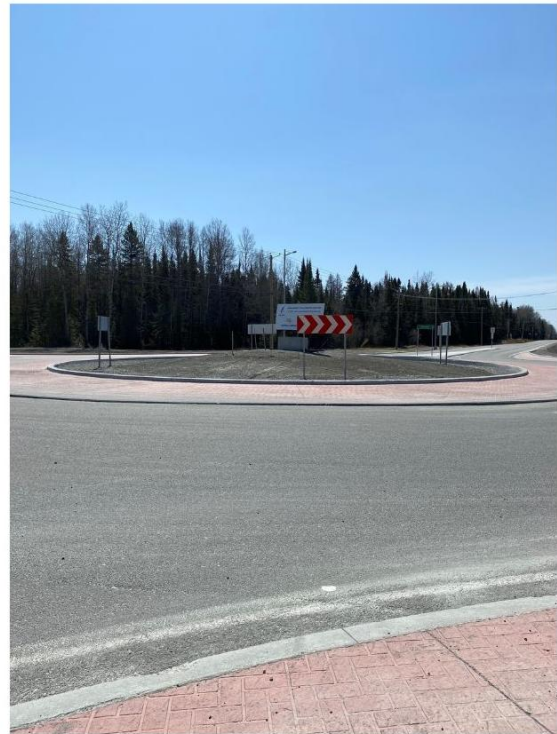
Vue vers le sud (vers l'aéroport) 7e Rue
