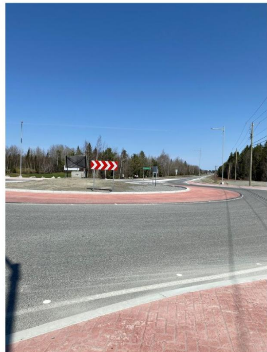
Vue vers le nord (centre-ville) 7e Rue
